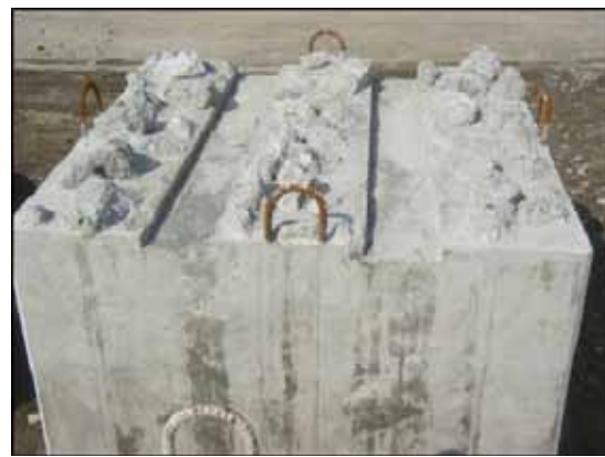
天端面にはコンブ科の海藻類が着生しやすいようにコンクリートがらで大きな突起を形成し、アワビが生息しやすいように溝を形成
