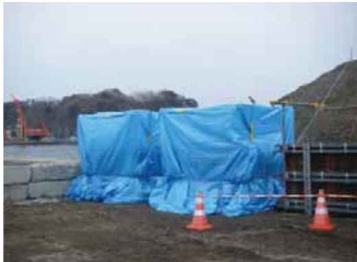
打設後の保温養生(レンタン設置)
