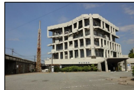
地震により被災した庁舎
