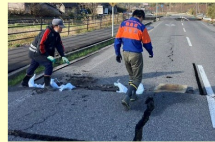
1月2日、輪島市門前町において、輪島市消防団が、道路の亀裂部分に土嚢を埋め、通行を可能とする応急対策を実施
