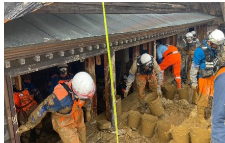
9月23日、珠洲市大谷町において、緊急消防援助隊の富山県隊、福井県隊が、がけ崩れ現場で救助活動を実施
