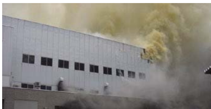
コンベア火災が発生したごみ処理施設
