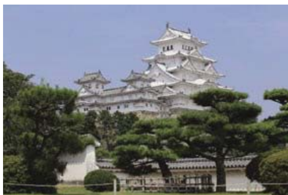
建物総合損害共済の対象となる姫路城 (提供：姫路市)
