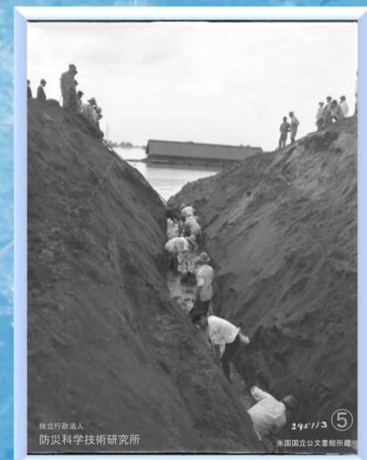
江戸川堤防掘削
