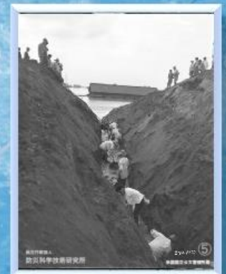
江戸川堤防掘削
