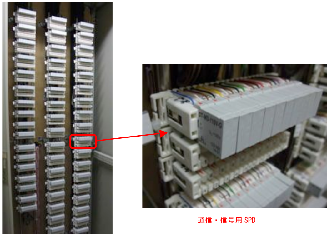
■4-11 MDF 盤への通信・信号用 SPD 設置例
